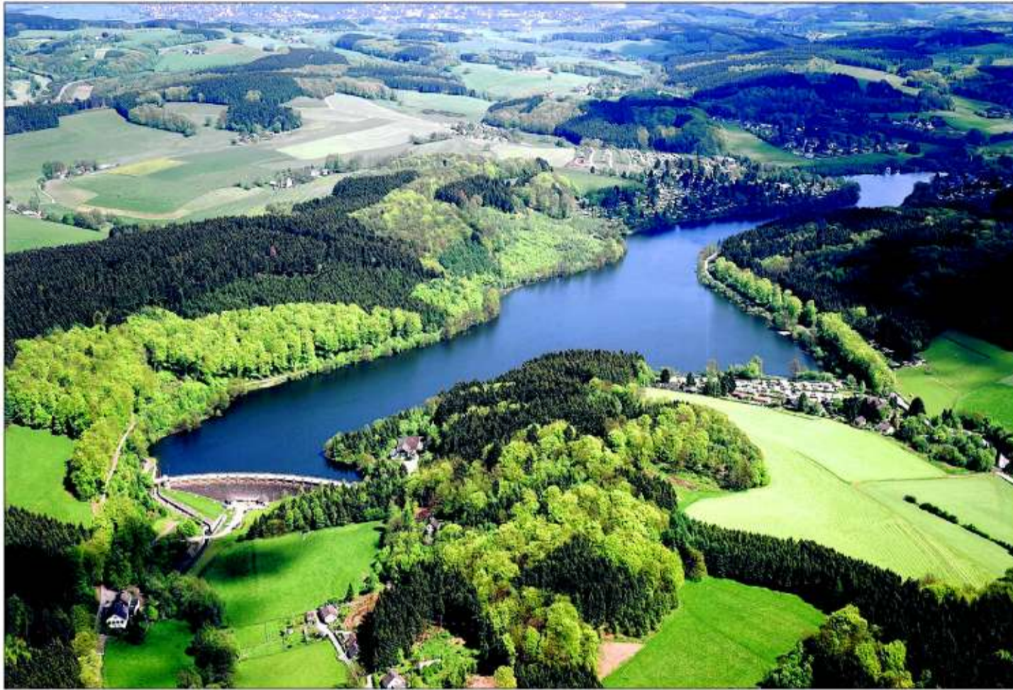
Die kleinste Talsperre im „Wasserquintett“: die Lingese in Marienheide. (Foto: Stuttgarter Luftbild Elsäßer GmbH/Wupperverband)
