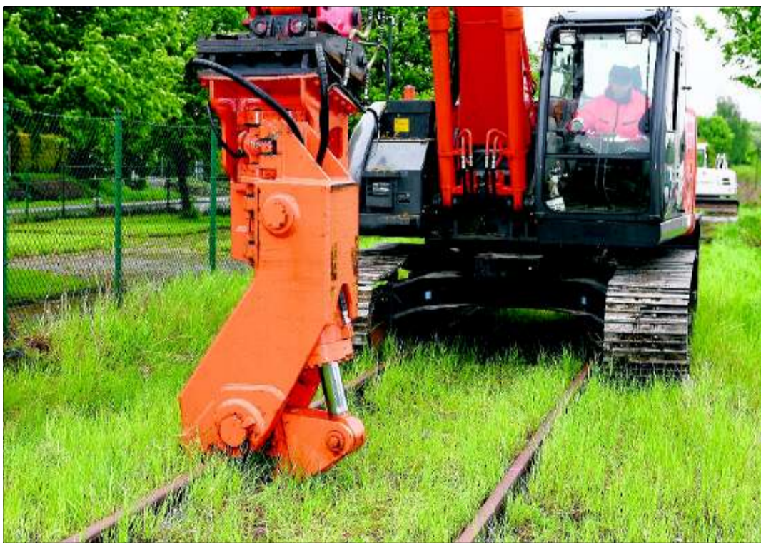
Der Schienenknacker bei der Arbeit. (Foto: Schmitz)
